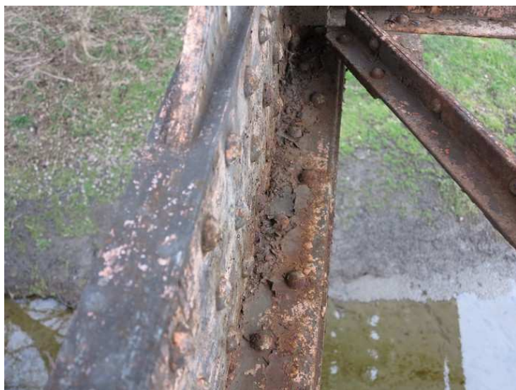
Foto č. 4 K 02 - dolní úhelníky, oslabení korozí
