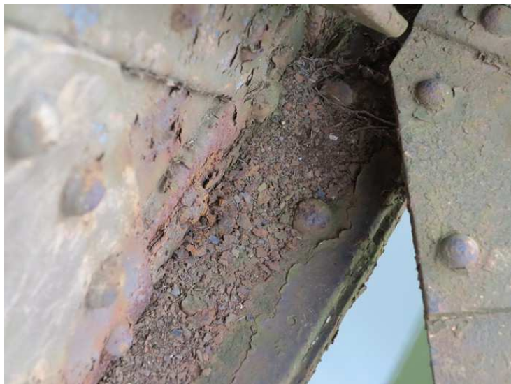
Foto č. 1 K 01 - dolní úhelníky, oslabení korozí
